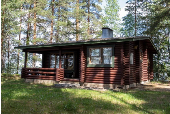
Vuonna 1978 rakennettu lomarakennus, jonka kerrosala on 42 m 2 .
