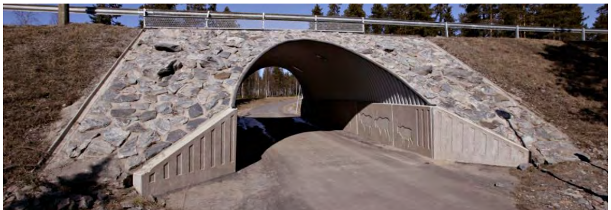
Kuva 13. Havainnekuva teräsisestä holvisillasta
