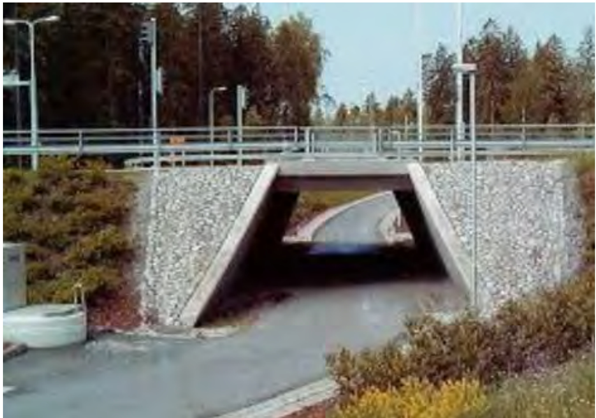
Kuva 12. Havainnekuva teräsbetonisesta laattakehäsillasta. (Petteri Pakkanen)
