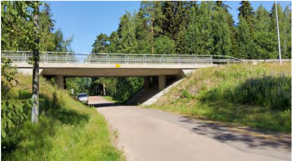
Kuva 14. Havainnekuva teräsbetonisesta ulokelaattasillasta.
