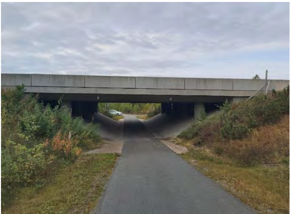
Kuva 15. Havainnekuva teräsbetonisesta ulokelaattasillasta betonikaiteella.
