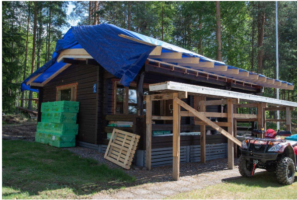
Vuonna 1978 rakennettu lomarakennus, jonka kerrosala on 42 m 2 .
