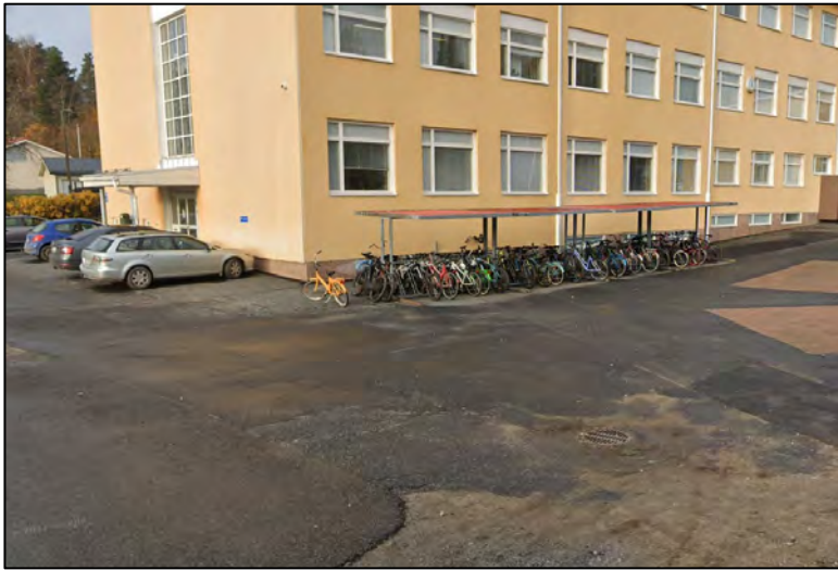
Kuva 6: Sadevesikaivo koulun Koulutien puoleisella alueella.
