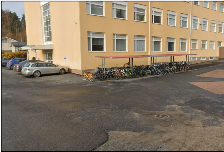
Kuva 6: Sadevesikaivo koulun Koulutien puoleisella alueella.
