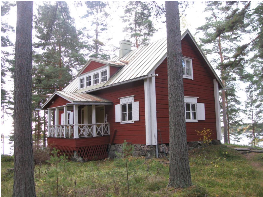
Kuva 11. Kukkiasaaren vanhan rakennuspaikan loma-asunto.
