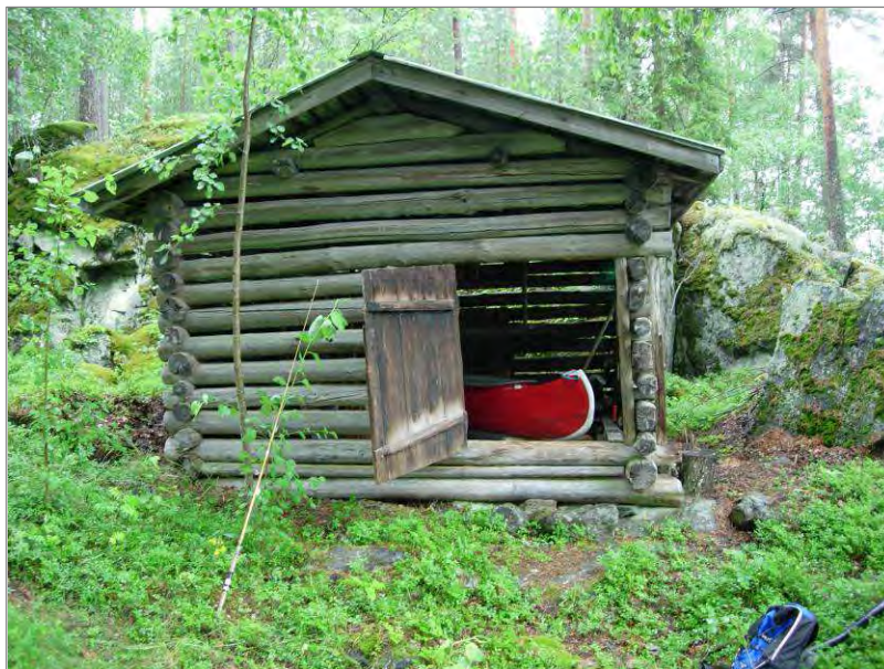
Kuva 40. Verkkovaja kuvattuna länsilounaasta.
