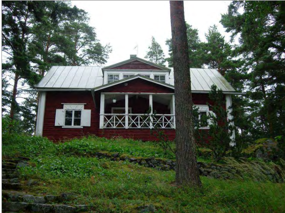
Kuva 15. Rakennuksen läntinen, järvenpuoleinen julkisivu. Kuvattu lounaasta.
