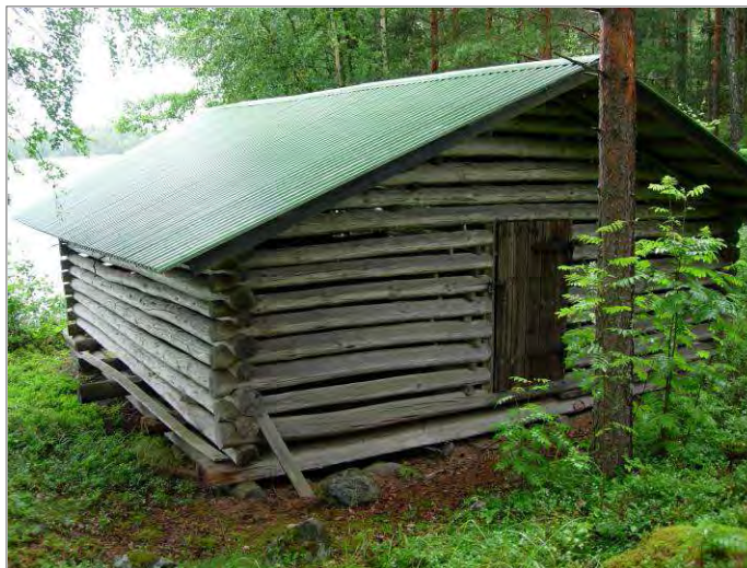
Kuva 44. Venesuoja kuvattuna kaakosta.
