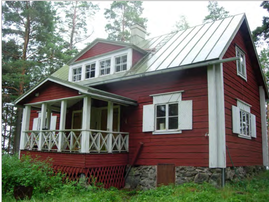
Kuva 19. Itäinen eli metsänpuoleinen julkisivu. Kuvattu koillisesta.
