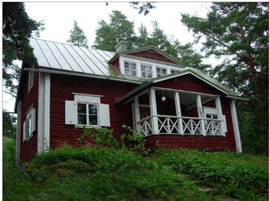
Kuva 16. Rakennuksen läntinen, järvenpuoleinen julkisivu. Kuvattu länsilounaasta.
