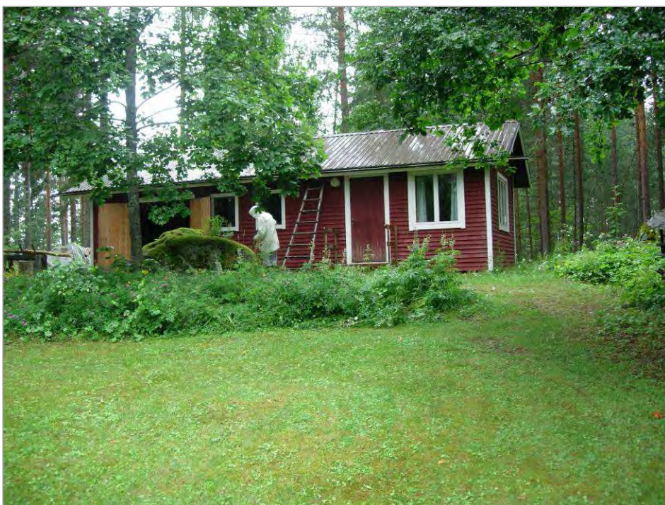
Kuva 36. Talousrakennuksen julkisivu kuvattuna etelästä.
