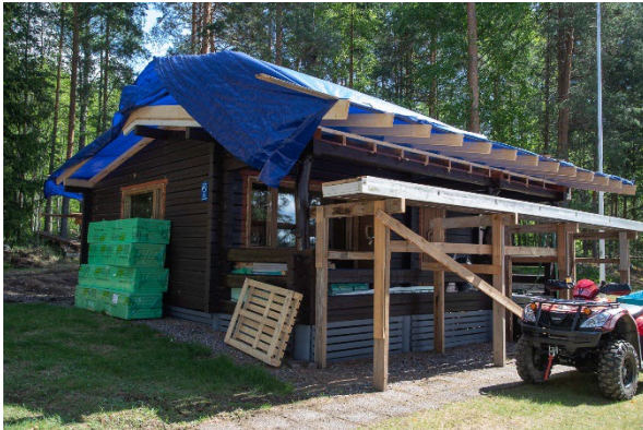
Vuonna 1978 rakennettu lomarakennus, jonka kerrosala on 42 m 2 .
