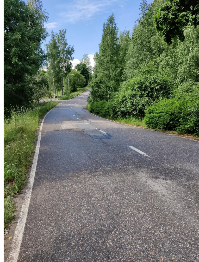
Kuva 13. Keskitie 18:n kohdalta länteen
