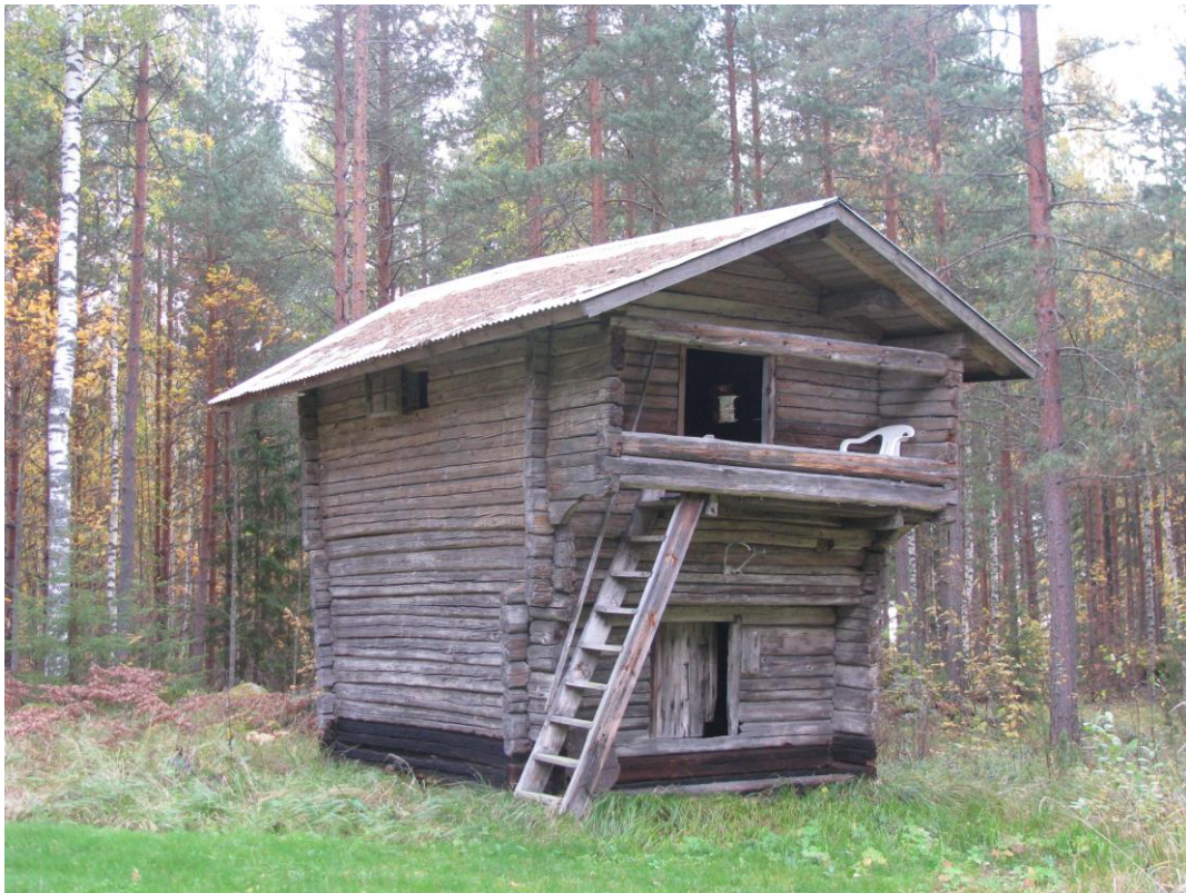
Kuva 13. Kukkiasaaren vanhan rakennuspaikan aittarakennus.
