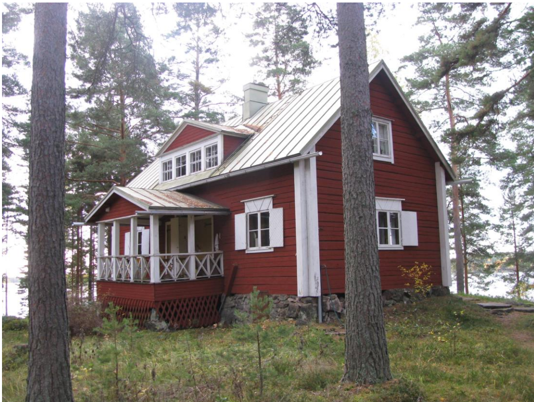
Kuva 11. Kukkiolan saaren vanhan rakennuspaikan loma-asunto.
