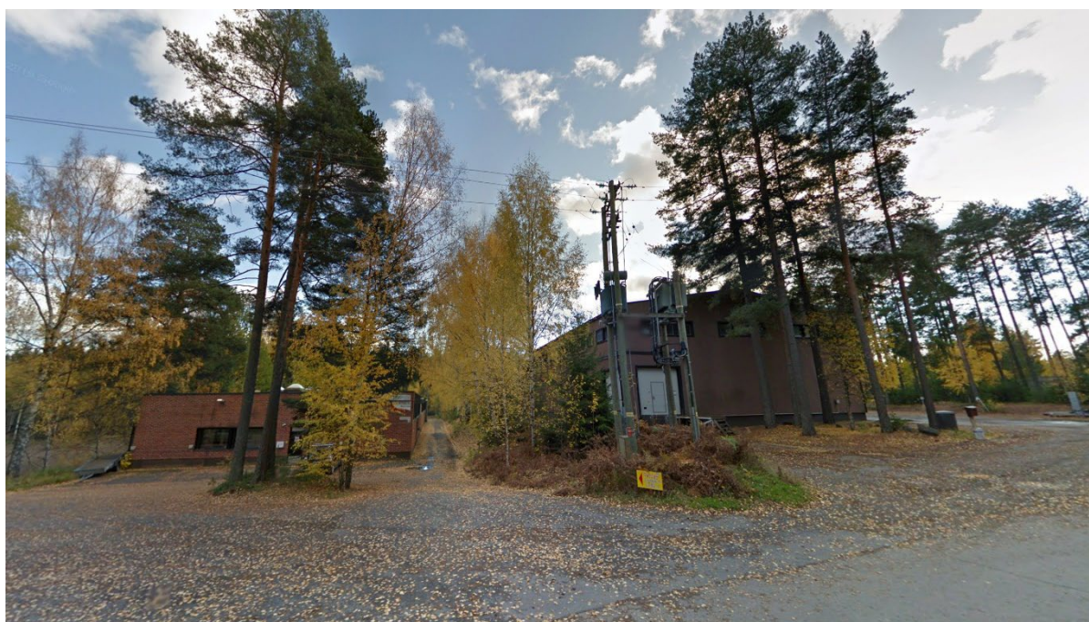
Takojantien varren teollisuusrakennukset. Lähde: Google Maps.
