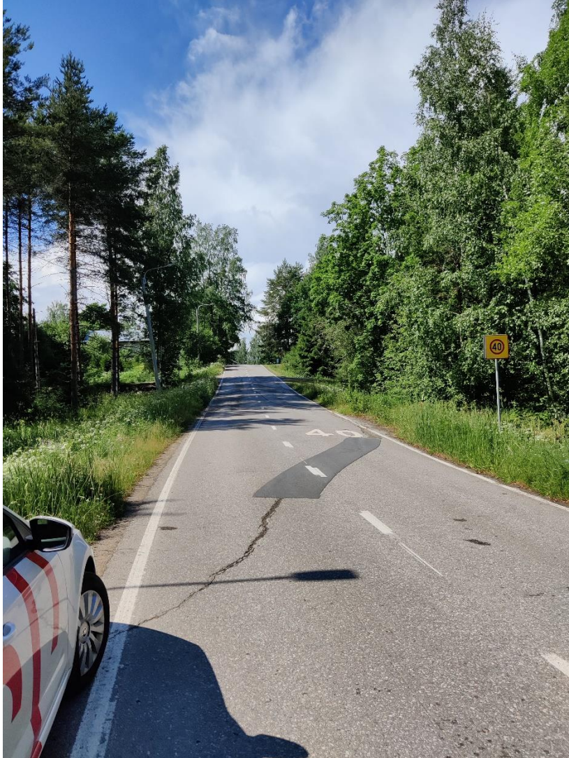
Kuva 14. Keskitie litainpolun kohdalla (kohtaamiskätkemä pienimmillään 48 m)
