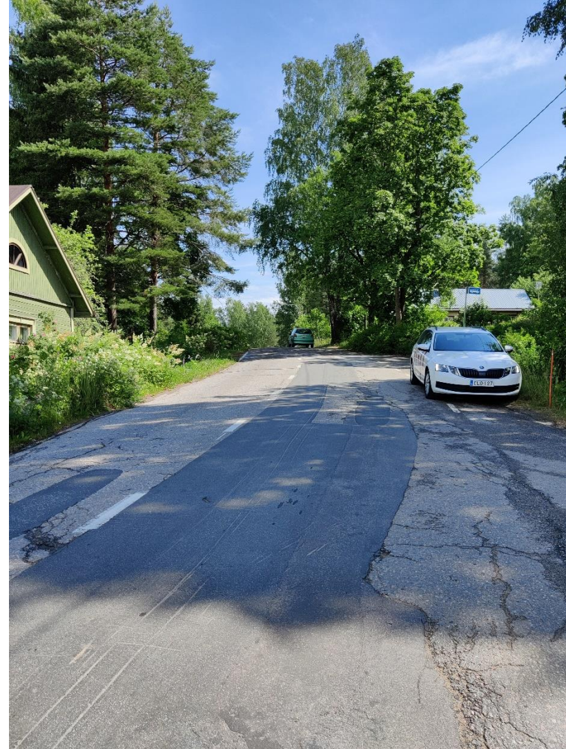
Kuva 15. Keskitie litainpolun kohdalla (kohtaamiskätkemä pienimmillään 48 m)
