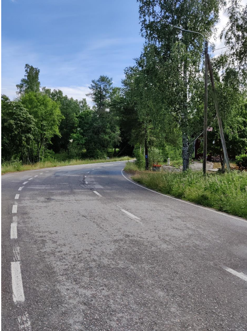
Kuva 8. Keskitie 18:n kohdalla. Kohtaamisnäkemä nykyisin alle 20 m ja edellyttää näkemäraivauksia tontilla.
